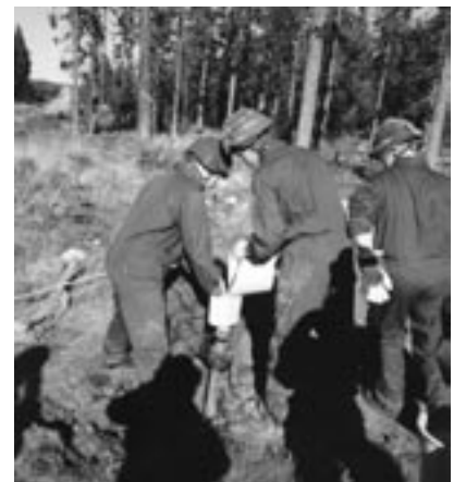
Figur 5: Järnröret fylls med flingad trotyl genom en tratt.
